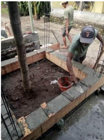
**Gambar 2.** Proses Pembangunan Ruang Oven Kapelan (bahan cetakan)
